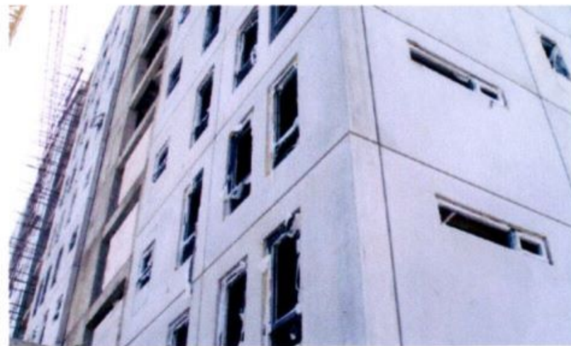
图 4 天津万科东丽湖工业化一期住宅楼预制墙板
