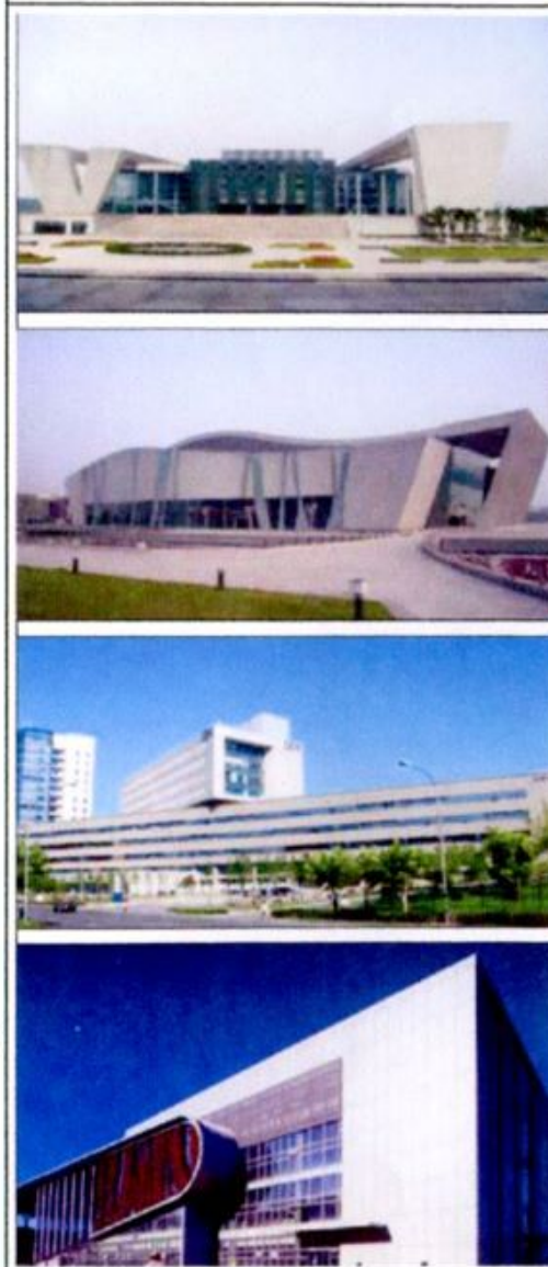
清水混凝土饰面外墙挂板工程
