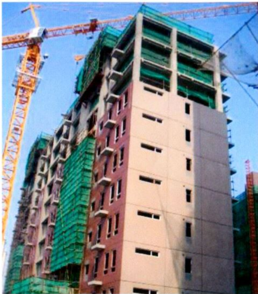
图 2 上海万科新里程项目 21 号住宅楼
